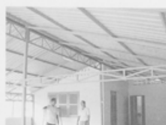
屋上には屋根が誕生
