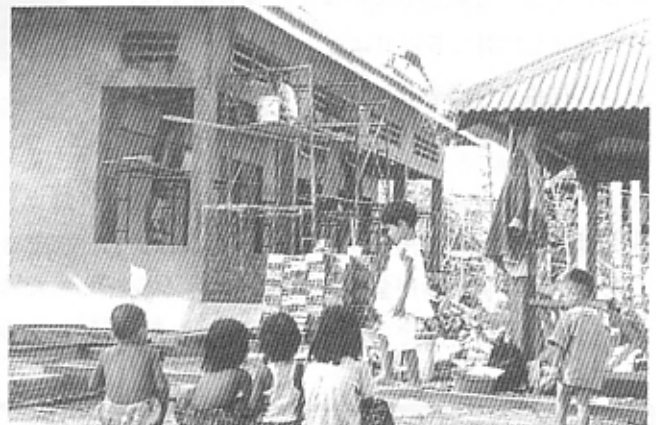
建設中の保育所 Childcare Center in construction
