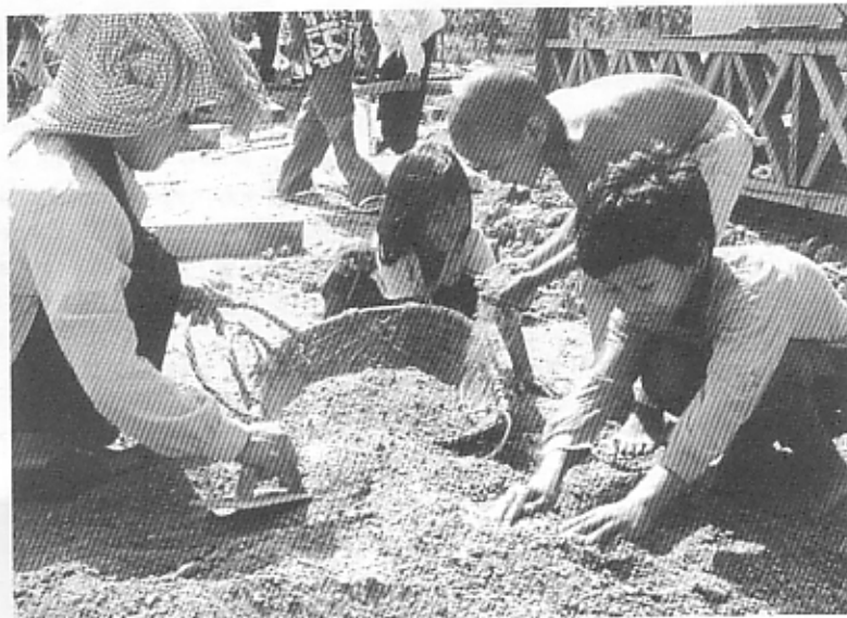
建設現場で手伝いをする子どもたち Children helping with work
