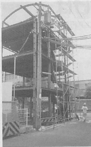
建設中の3階建てのアジアハウス
