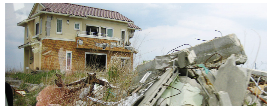
国道沿いの道で津波被害を受けた家と流されてきた倒壊物。2014年5月
